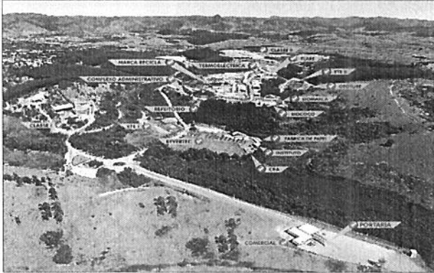
Figura 47- Vista aérea da Central de Tratamento da Marca Ambiental e unidades do empreendimento
