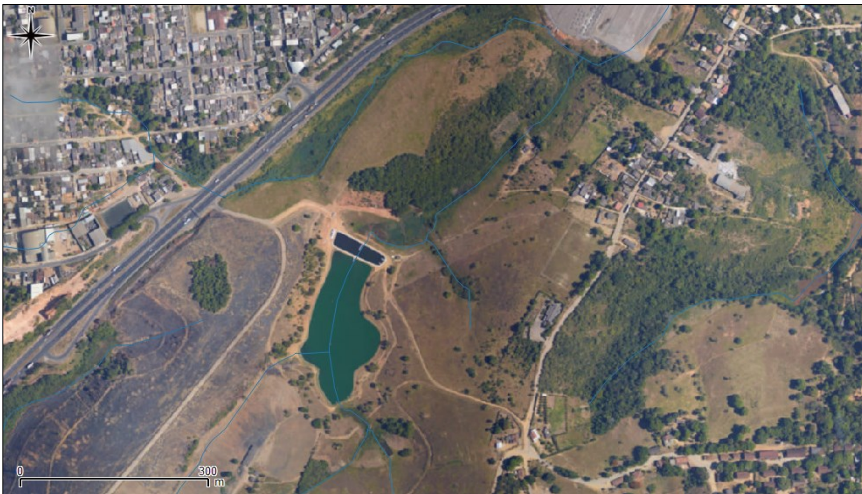
Figura 77 – Ponto de lançamento de esgoto tratado na ETE Nova Rosa da Penha.
