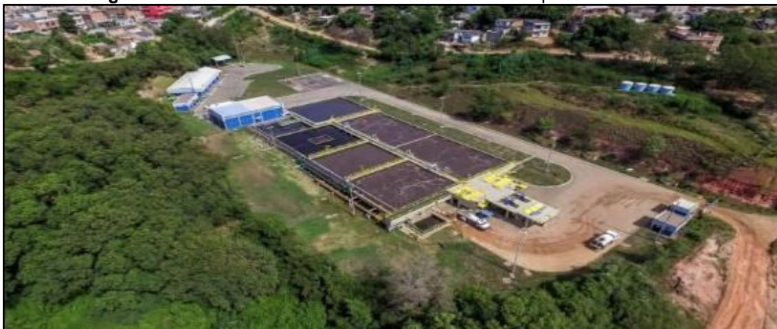
Figura 36 – ETE Bandeirantes: sistema de tratamento por lodos ativados.
