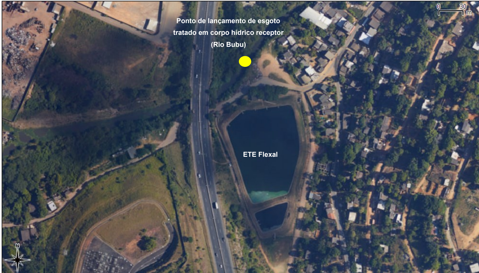
Figura 66 – Ponto de lançamento de esgoto tratado na ETE Flexal.
