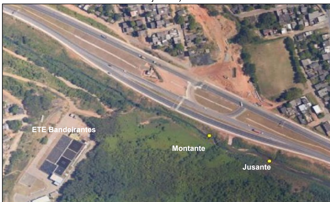
Figura 55 – Pontos monitorados em corpo hídrico receptor – Córrego Campo Grande (montante e jusante).
