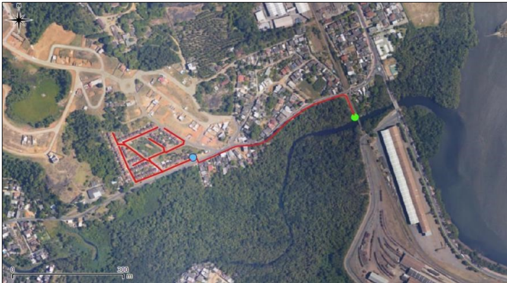
Figura 89 – Ponto de lançamento de esgoto tratado na ETE Vila Oásis (Córrego Piranema).
