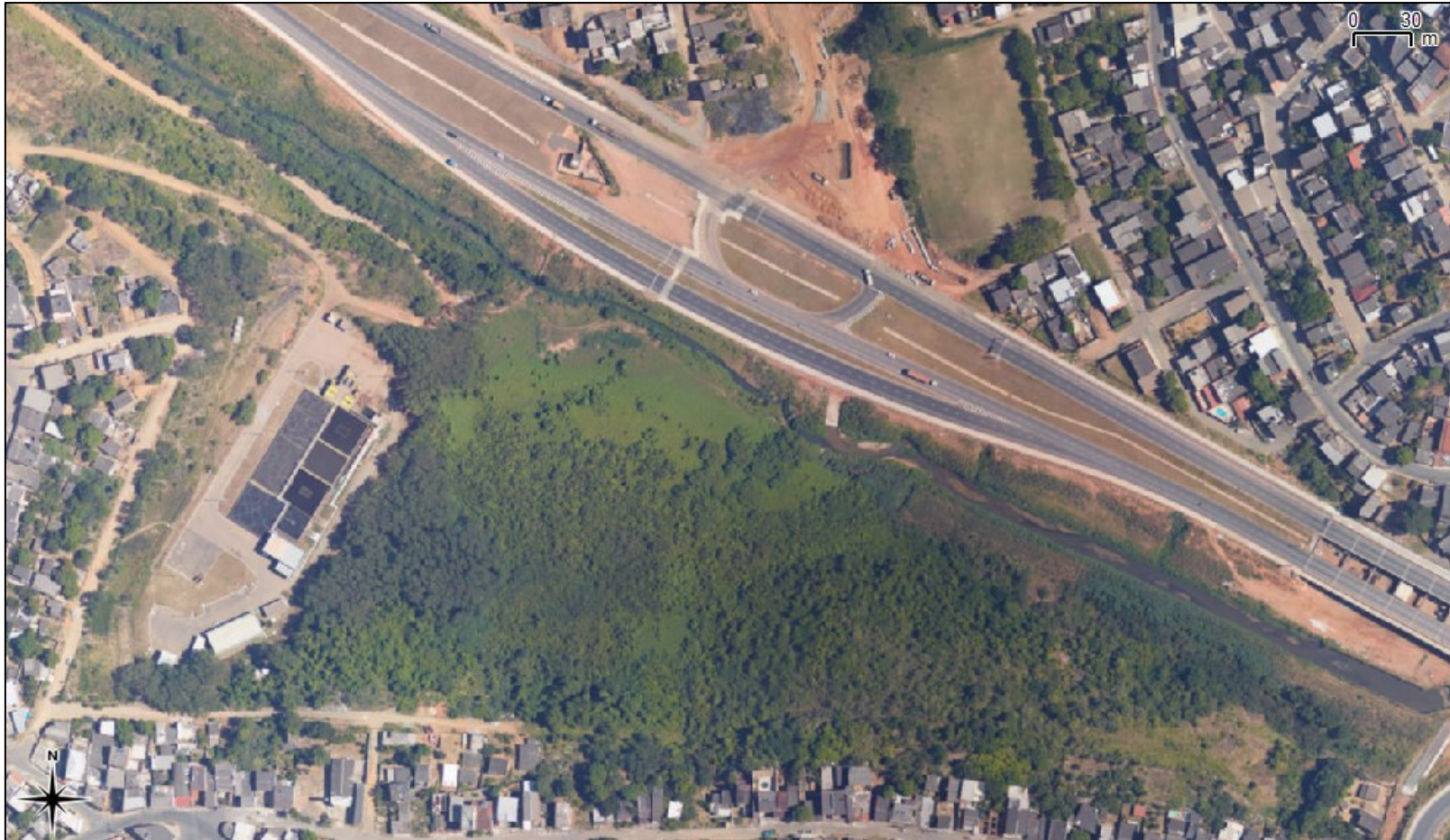
Figura 54 – Ponto de lançamento de esgoto tratado na ETE Bandeirantes.
