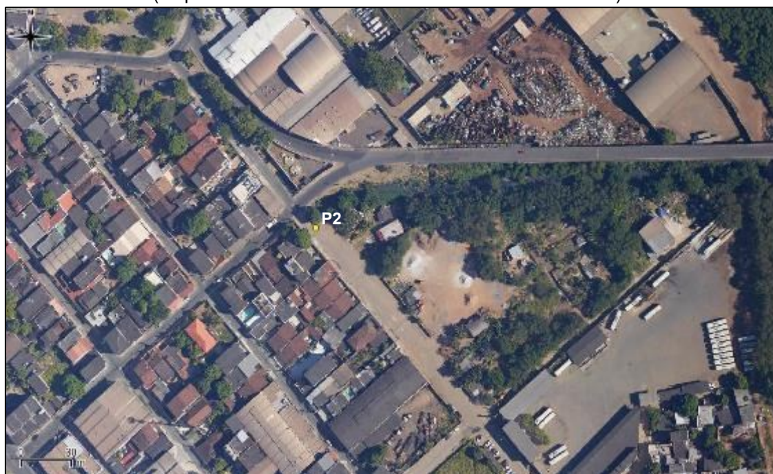
Figura 59 – Ponto monitorado - Canal de drenagem Jardim América, descida da segunda ponte (esquina entre as Avenidas América e Minas Gerais - P2).
